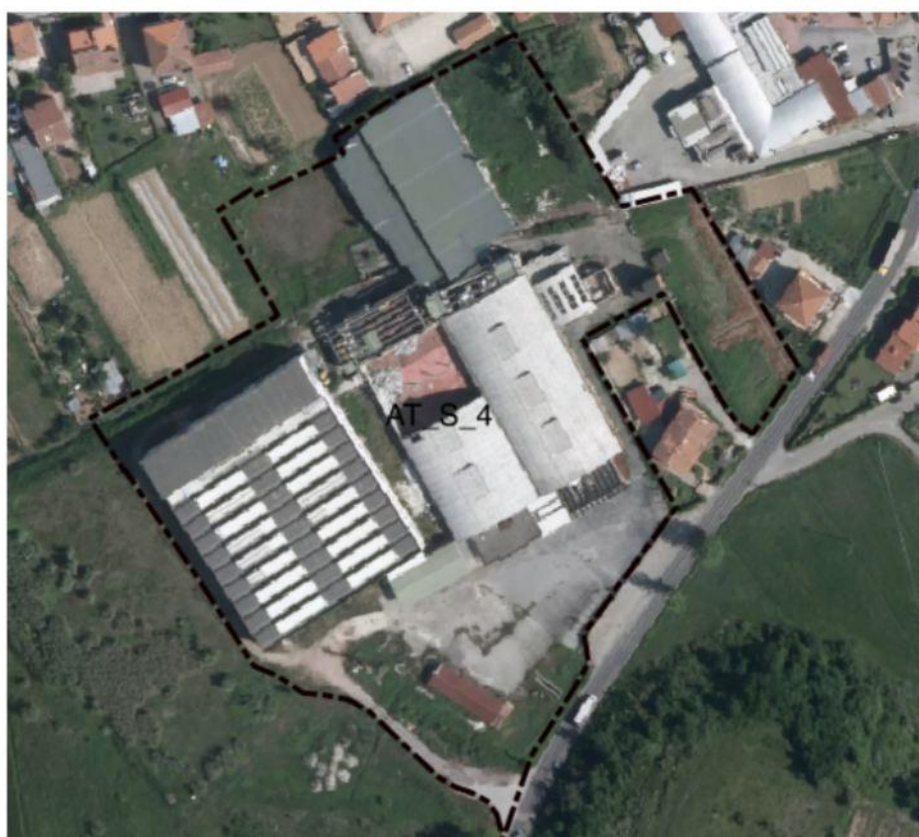
16. Illustrazione: foto aerea ove si rileva porzione del capannone crollato
