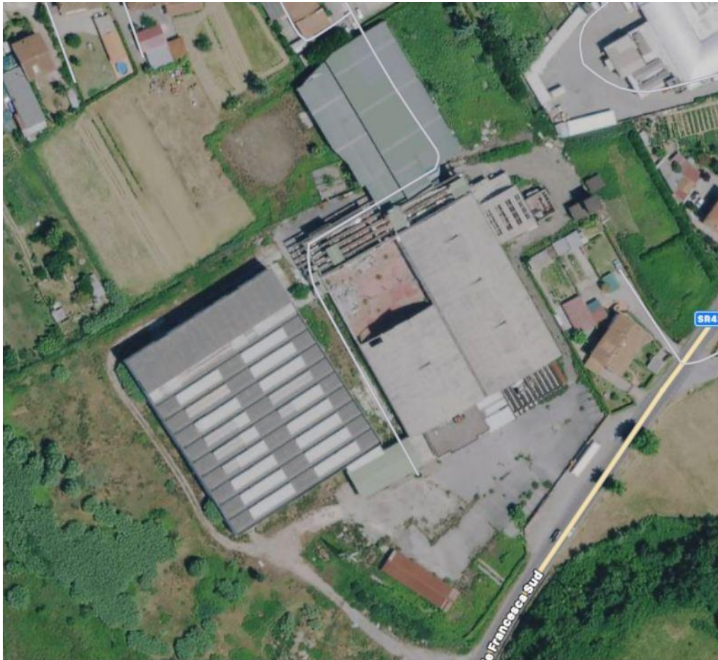
2. Illustrazione: particolare del complesso edilizio e terreni
